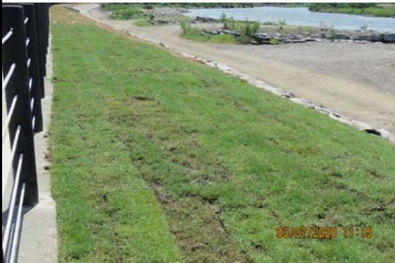
2. 目前已完成綠化植草作業，現場機具已退場。若培厚土方因雨季有沖蝕流失，會再由原有施工動線進入進行修補。
