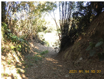
八工區原溝渠旁既有便道回復情形
