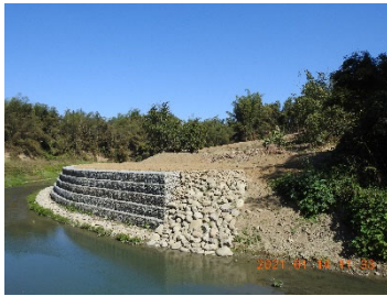
七工區堤頭(尾)緩坡拋石護坡
