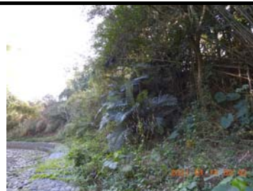
五工區石籠旁邊坡之次生林及生態保全對象(山棕)未擾動
