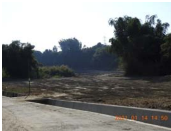
二工區施工便道利用既有道路
