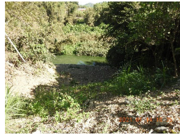
八工區侵蝕溝坍方邊坡已填補平順
