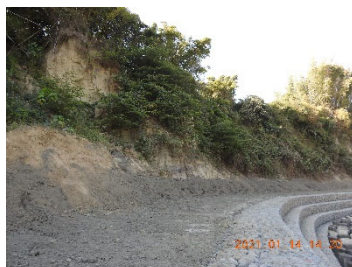
二工區範圍以最小利用為原則，邊坡上方為道路，除坍塌處外，邊坡的次生林皆保留
