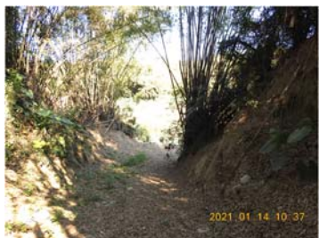
八工區原溝渠旁既有便道回復情形
