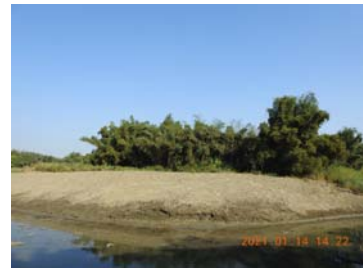
二工區河道整理作業未擾動到深槽棲地，僅將淤積土方覆於草生地邊坡上，亦無擾動後方次生林
