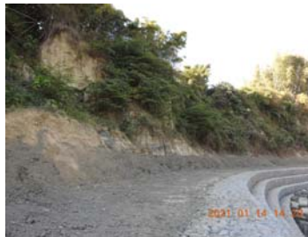
二工區範圍以最小利用為原則，邊坡上方為道路，除坍塌處外，邊坡的次生林皆保留
