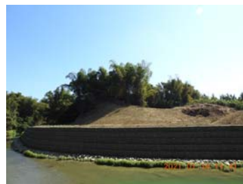
七工區因地形限制，新闢施工範圍較大，但已盡量保留原本陸域竹林
