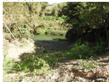
八工區侵蝕溝坍方邊坡已填補平順
