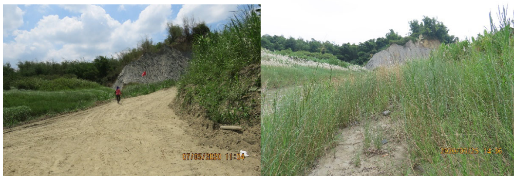
圖 5-24 108 年度二仁溪南興橋上下游段防災減災工程三工區下游他案疏濬工程便道之植被已回復 左：5 月疏濬中施工便道、右：9 月完工後
