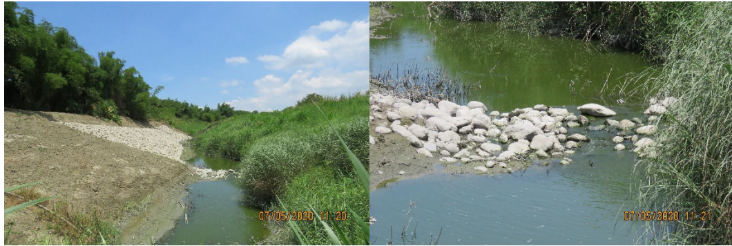
圖 5-23 108 年度二仁溪南興橋上下游段防災減災工程三工區下游水域棲地營造
