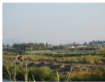
一工區對岸現有工程施作，部分草本植被已被剷除
