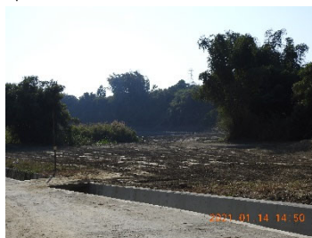
二工區施工便道利用既有道路
