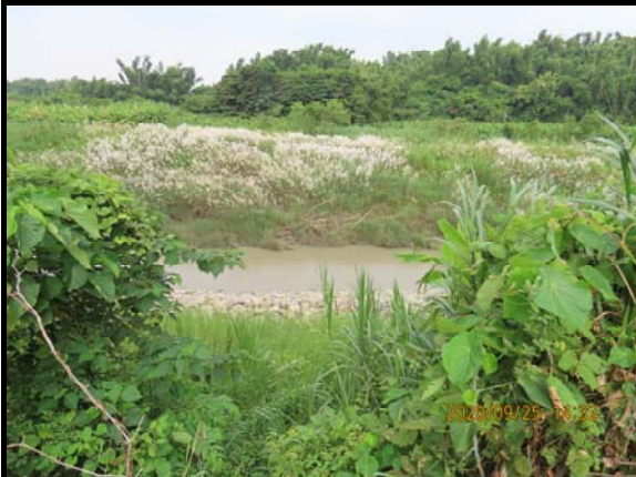
三工區砌石上方填土區已自然回復。
