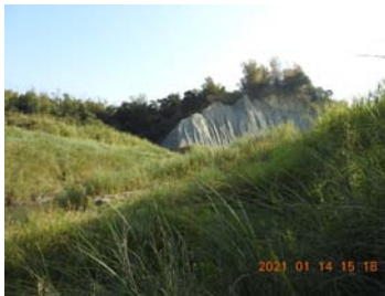
三工區利用他案疏濬工程便道進場施作，其場域的高莖草本植被已完全回復
