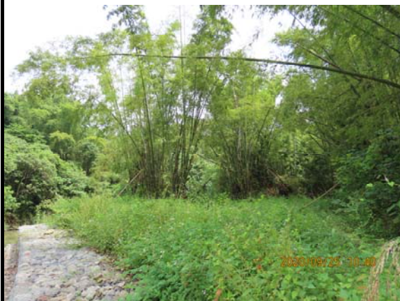
五工區堤後覆土區已有植被生長。
