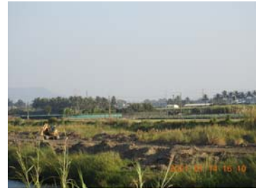
一工區對岸現有工程施作，部分草本植被已被剷除
