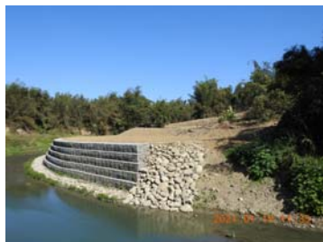
七工區堤頭(尾)緩坡拋石護坡
