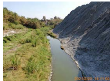
四工區石籠護岸堤頂已被自然回復的植被覆蓋，無法下切至溪流
