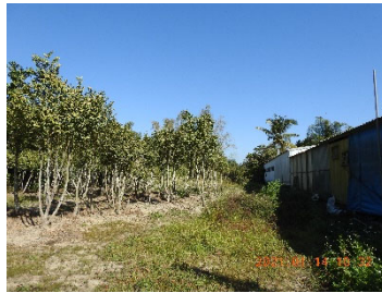
八工區施工便道優先利用已受干擾環境(陳情地主沉香林)
