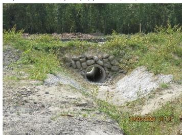
一工區石籠護岸設置排水涵管
