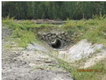
一工區石籠護岸設置排水涵管
