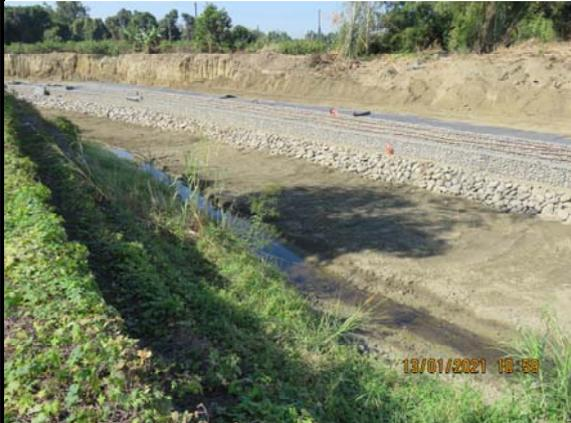
本工區涉及河道整理項目，為避免完工後河道開闢於乾季水位過低導致斷流，因此維持留設近左岸之導流溝，形成低水流路，維持溪水不斷流。
