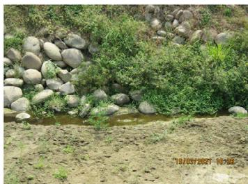
二工區留設近左岸之導流溝，形成低水流路，維持溪水不斷流
