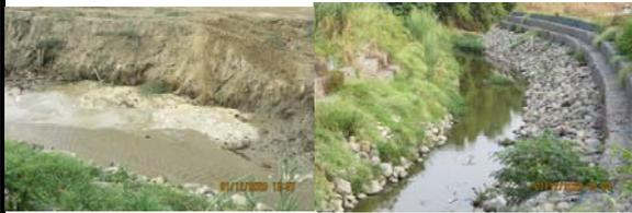
本工程因需進行河道整理，施作時土沙易造成水體濁度上升，影響範圍約 50 公尺，下游段因未擾動河道，經自然沉降後未致下游水域濁度太高。
