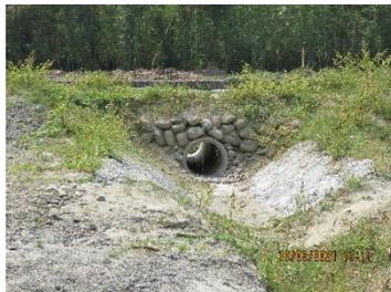
一工區石籠護岸設置排水涵管
