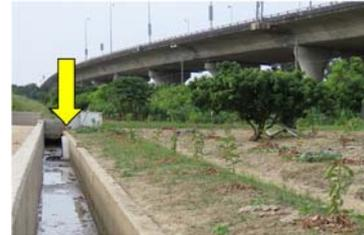
堤後排水溝設置梯形緩坡動物通道(電塔東側)
