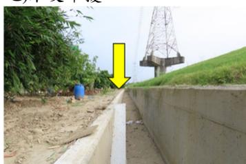
堤後排水側溝設置梯形緩坡動物通道(電塔西側)
