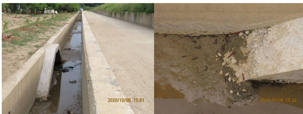
圖 5-4 曾文溪新中堤防防災減災工程併辦土石標售一工區堤後排水側溝動物通道設置情形
