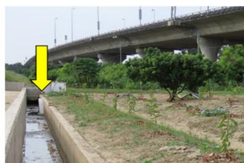
堤後排水側溝設置梯形緩坡動物通道(電塔東側)
