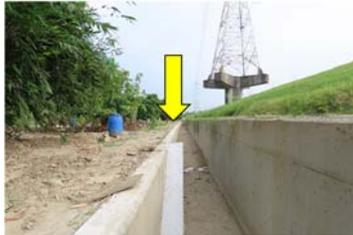
堤後排水溝設置梯形緩坡動物通道(電塔西側)
