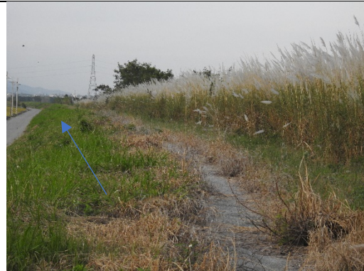
堤防內側環境照
