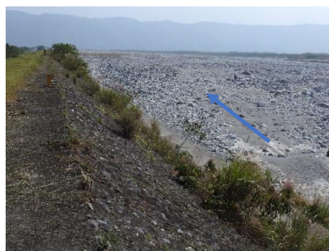
工區區段-水流左岸之堤防。(2019.11.14)
