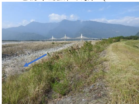
工區段-水流左岸之堤防。(2019.11.14)
