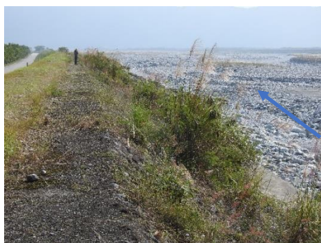
工區段-水流左岸之堤防。(2019.11.14)
