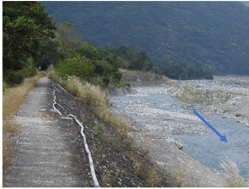
工區段-水流右岸之堤防多為混凝土基質。 (2019.11.14)
