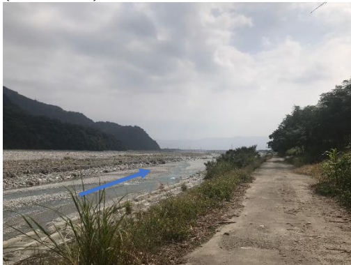
工區段-水流右岸之堤防。(2019.11.14)
