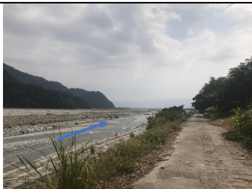
工區段-水流右岸之堤防。(2019.11.14)
