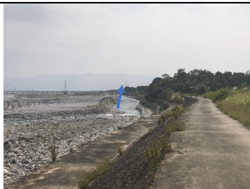
工區段-臨水側護岸多為陡直，嚴重影響橫向地景之連結。(2019.11.14)
