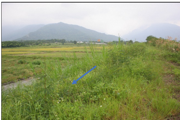
堤防內側環境照
