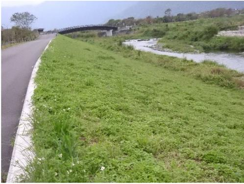
圖2 荖溪萬壽堤防前坡植被回復狀況
