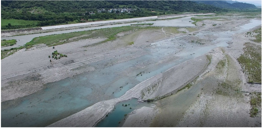
工區段空拍紀錄。(2020.09.11)
