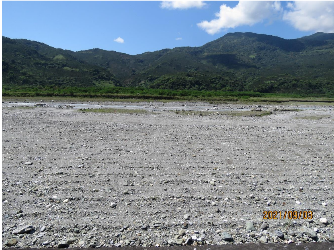
圖 4 馬太鞍溪導流堤工區狀況
