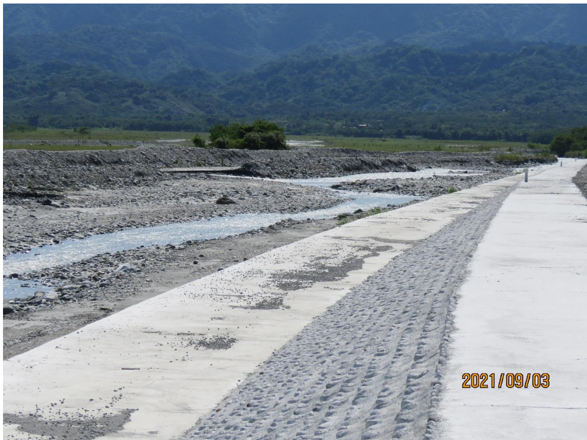
圖 3 光復二號堤段工區狀況
