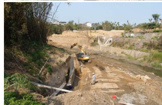
南港溪濫坑里護岸防災減災工程(一)施工過程民眾陳情，辦理現地會勘及說明會(1092/20)
