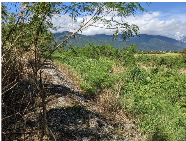
圖、電網跨越堤防至高灘地
