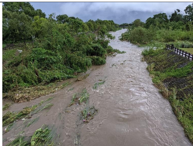
圖、圓規颱風豪雨沖刷南平橋下游左岸次生林 (110/10/12)
