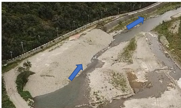
圖 4 110 年施作搶災搶險工程施作緩坡高灘地
