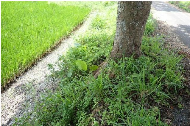
圖、堤後坡喬木根系裸露處
