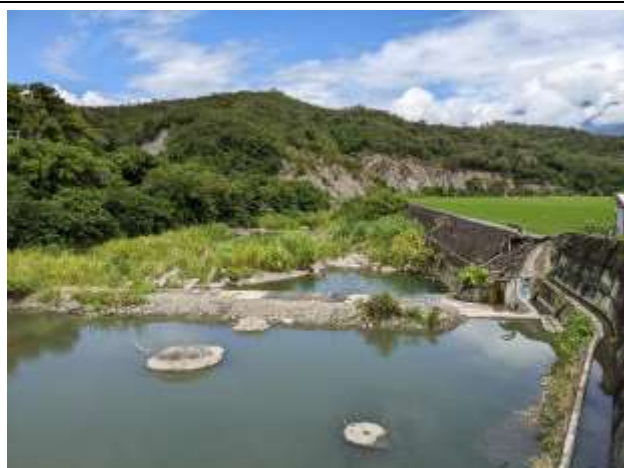
圖 3、池豐橋下游設置攔水土堤
