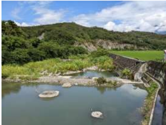
圖1、池豐橋下游設置土堤攔河堰取水
