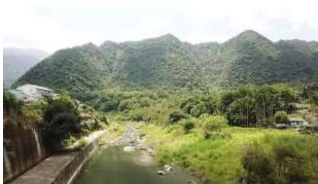
圖 8、工程範圍右岸為緩坡長草區
