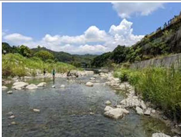
圖 6、工程起點往下游拍攝，溪床內較多塊石，為淺瀨環境
