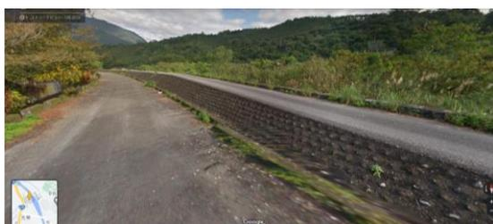
圖 5 和榮大橋上游結構物阻隔性低 (0-330 處)
