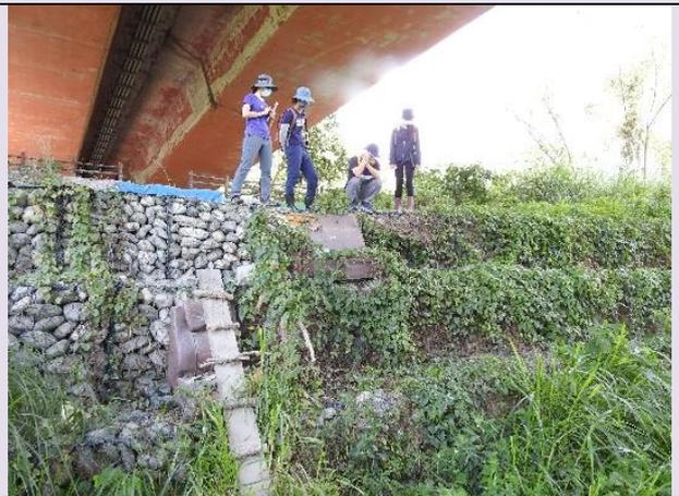
圖十二、工區右岸堤防現況為四層箱籠，有較大的垂直落差。(拍攝日期:111年4月27日)
