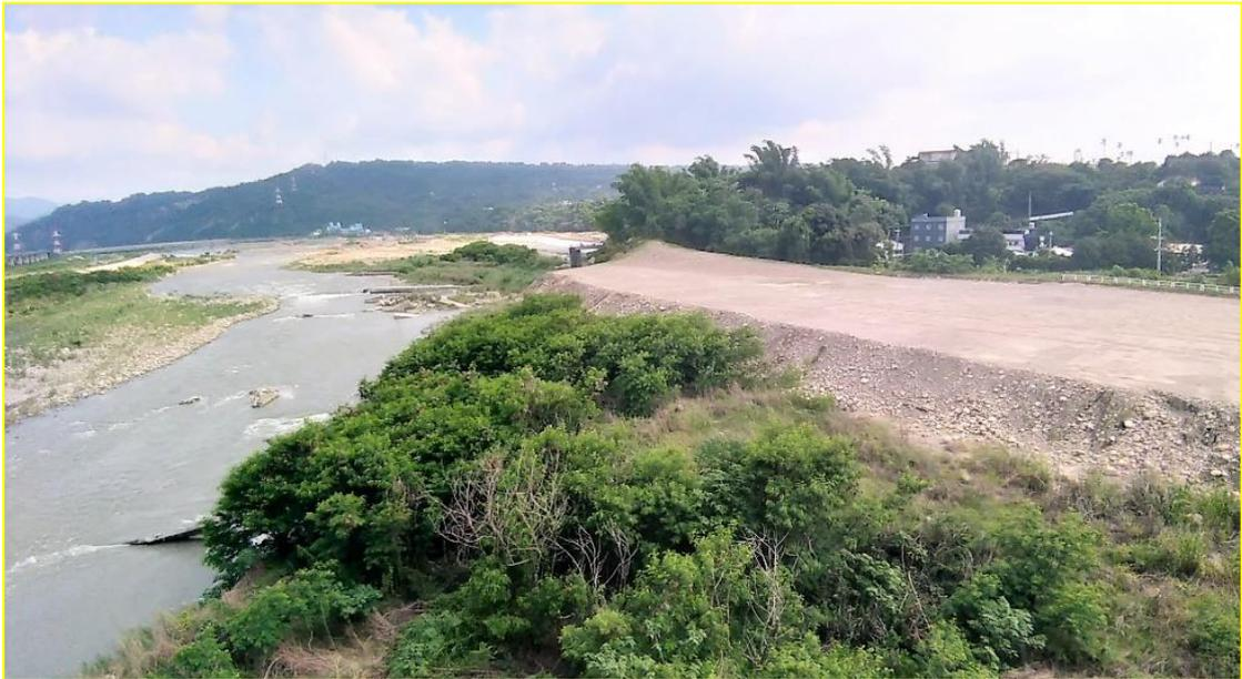
圖 9. 北勢堤防培厚區 2，不免縮減通洪斷面，並把流心往右岸推移，日後難不怕該岸之崩塌更趨嚴重？從六高上望，110-7-3。
