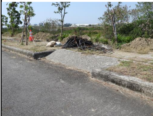
圖 B 道路路側落坎逃生斜坡案例
