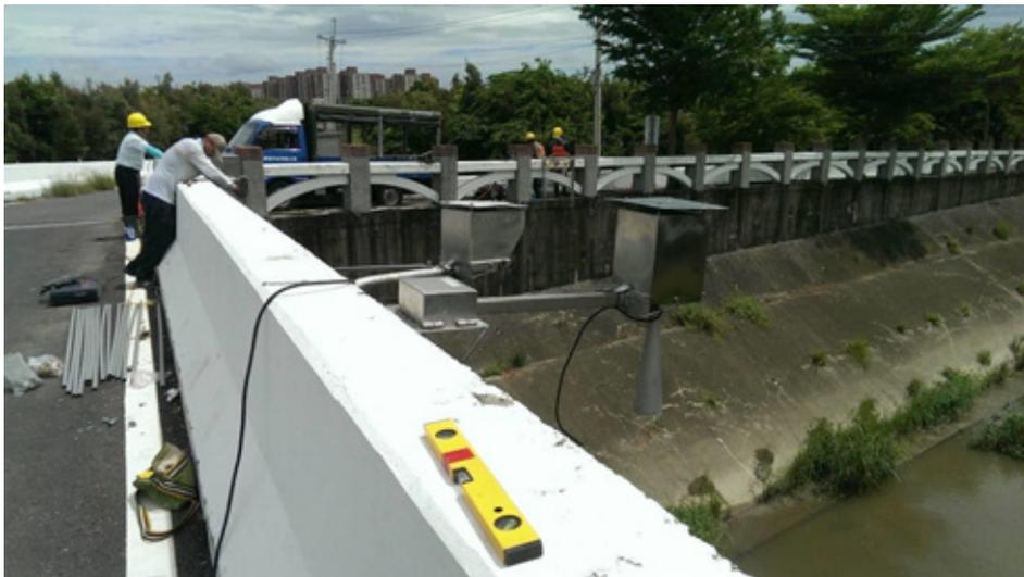
圖 2-21 典寶溪排水集水區寶公橋水位計及表面流速計
