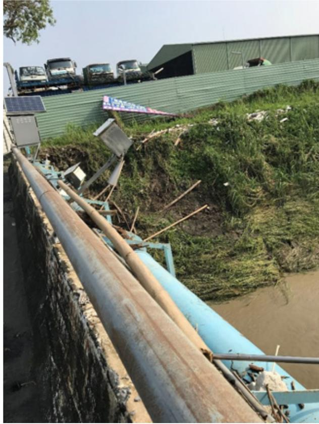
圖 6-29 典寶溪燕鳳橋於 2015 梅姬颱風期間遭受洪水夾帶漂流物衝擊損壞
