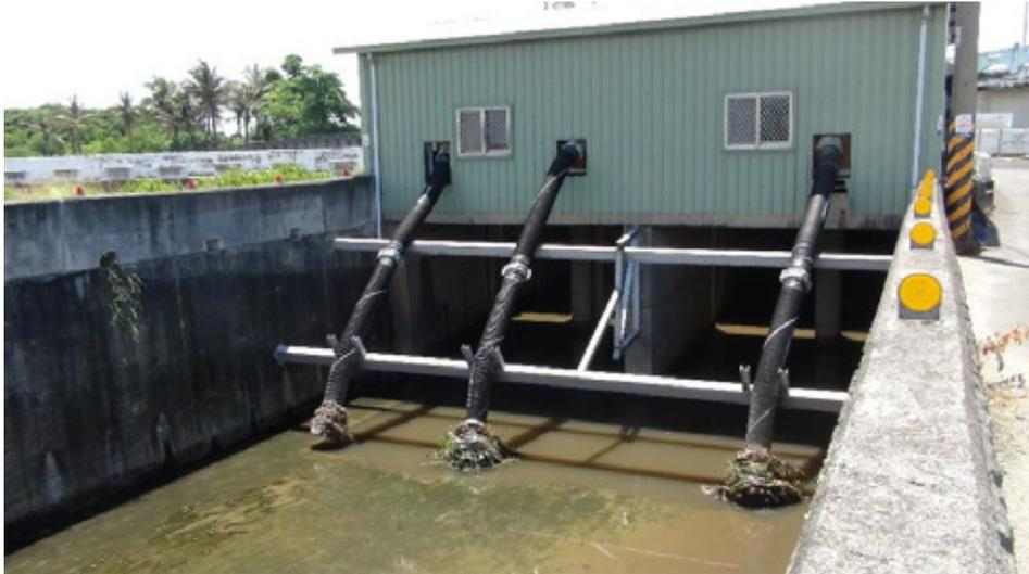
圖 3-15 典寶溪排水集水區潭子底溝移動抽水站
