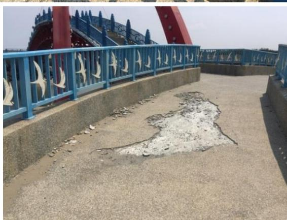
苑港漁港港區彩虹橋燈具損毀、欄杆生鏽損壞以及橋面鋪面破損
