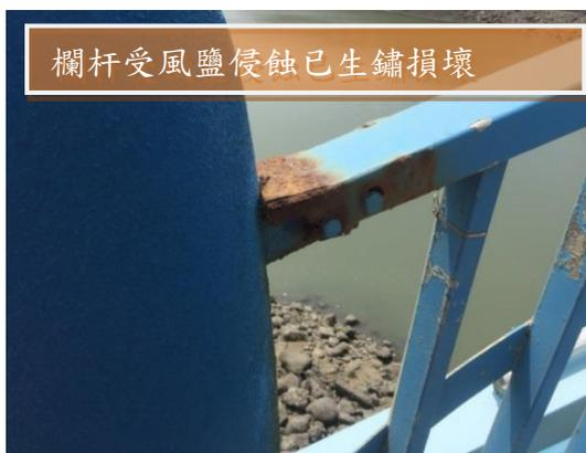
欄杆受風鹽侵蝕已生鏽損壞
