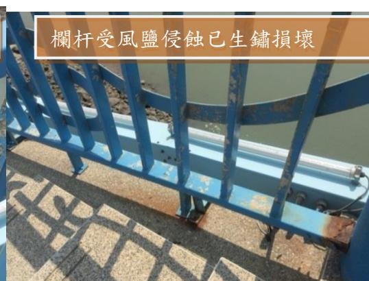
欄杆受風鹽侵蝕已生鏽損壞
