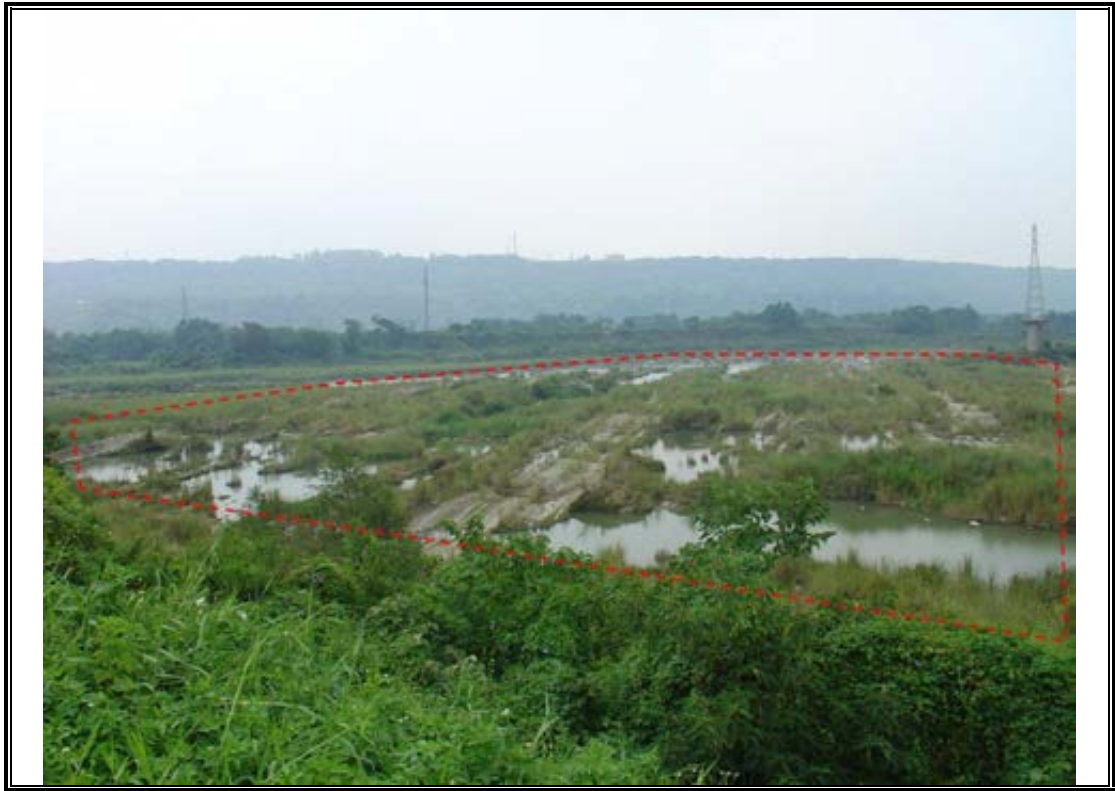
圖 6-37 阿姆坪隧道大漢溪堤後浮覆地現場照片
