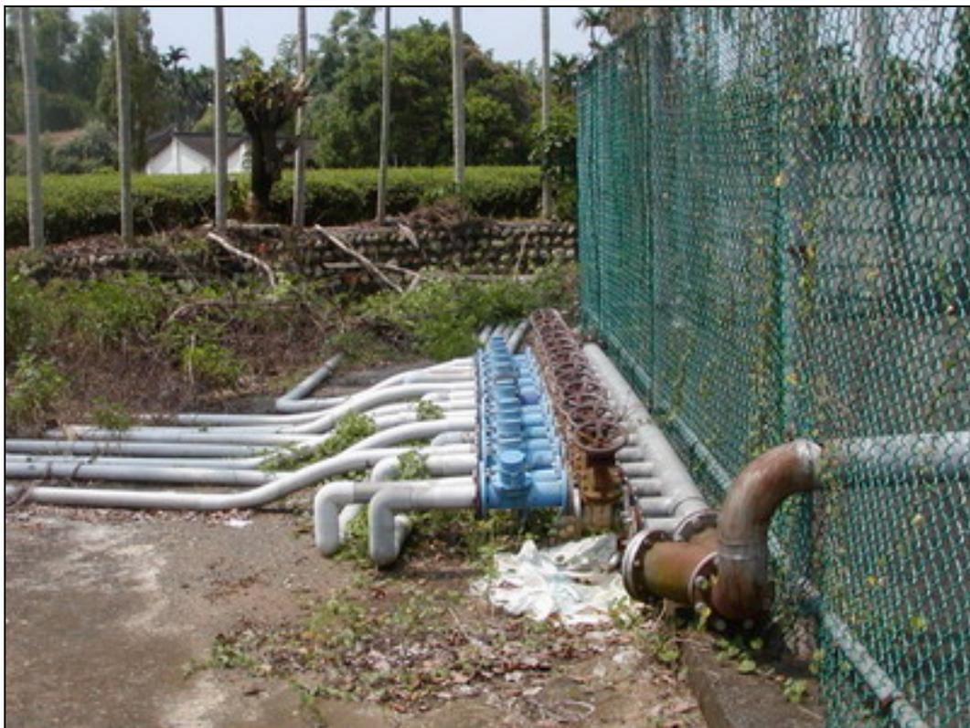
圖 4-11 蓄水塘輸水管路接管示意圖
