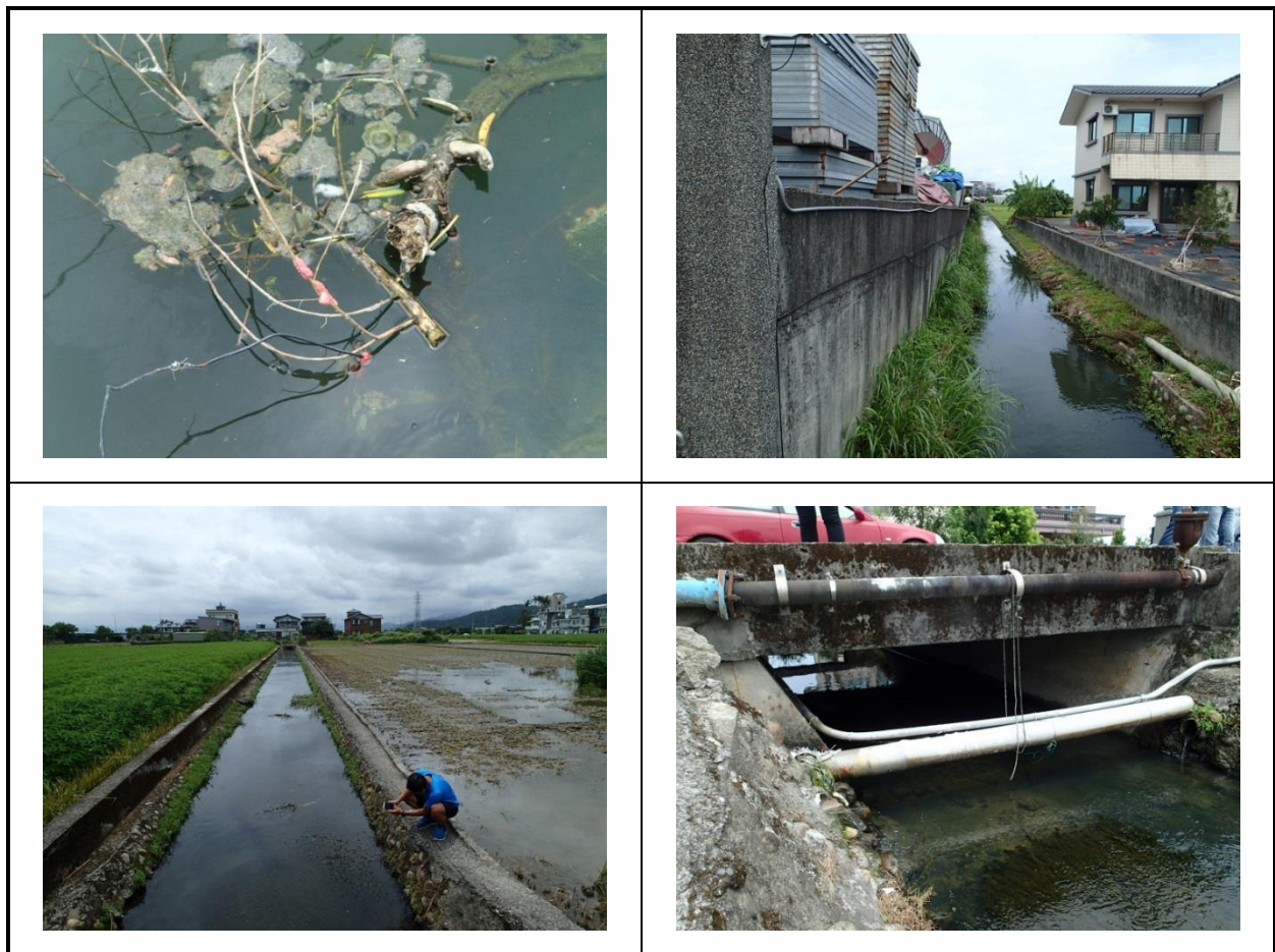
圖 3-9 七結排水 107 年 8 月 24 日環境現況紀錄照
