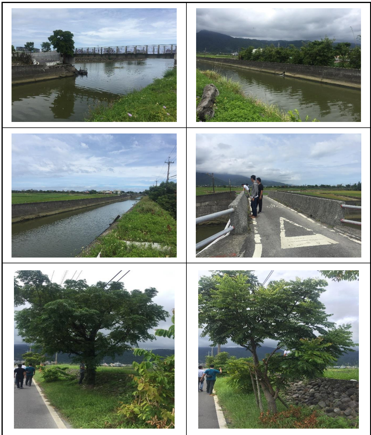
圖 3-10 下埔排水 107 年 8 月 24 日環境現況紀錄照
