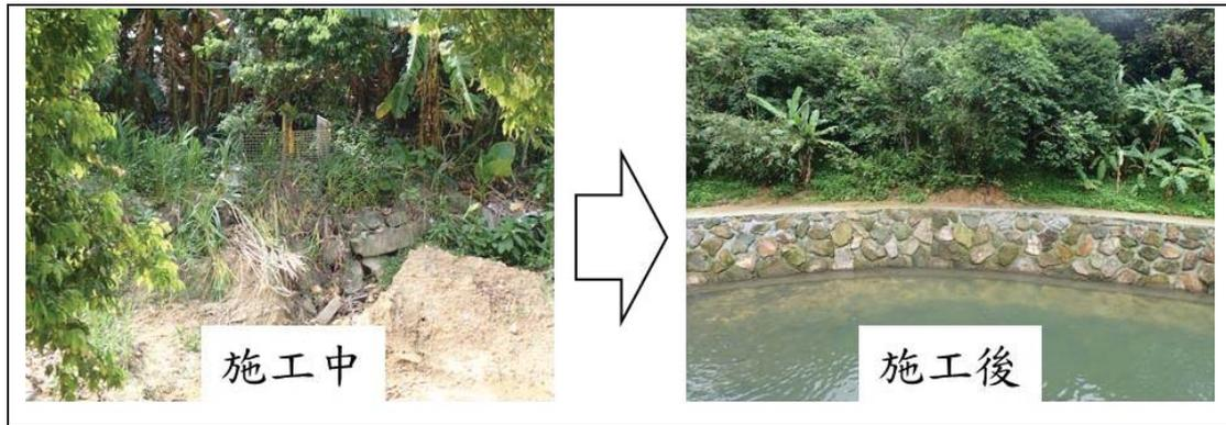
根據大武崙溪排水瓶頸改善工程生態保育對策執行對照表顯示，該工程單位在工程施作過程中，皆有確實執行生態保育對策，保留河道左右兩側之原有植被，且施作粗糙面較多之漿砌石護岸，以利於攀藤性植物蔓延，該工法一方面可達到工程必要性之結構穩定性，另一方面亦可達到環境友善之操作，於河道中央處亦有留一入水口，剛好可作為生物利用之通道。所保全之樹木亦可作為鳥類躲避及使用之棲位，給予生物應工程造成衝擊之緩衝區，亦可使當地生態較為快速回復。
