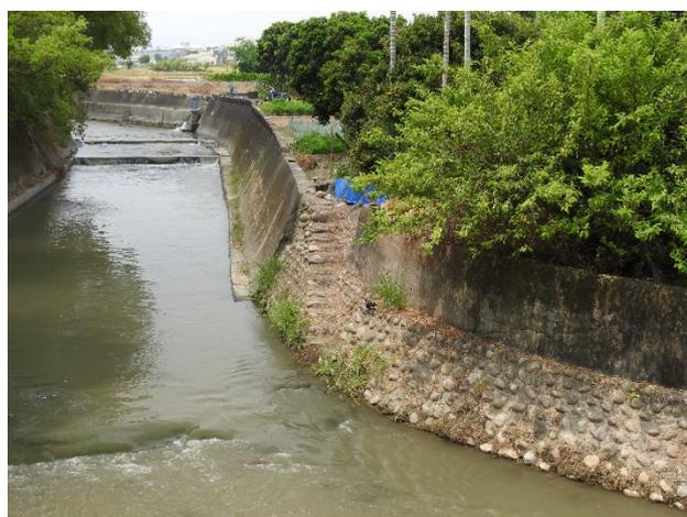
圖 42 早期漿砌石護岸工程設計進出渠道的階梯
