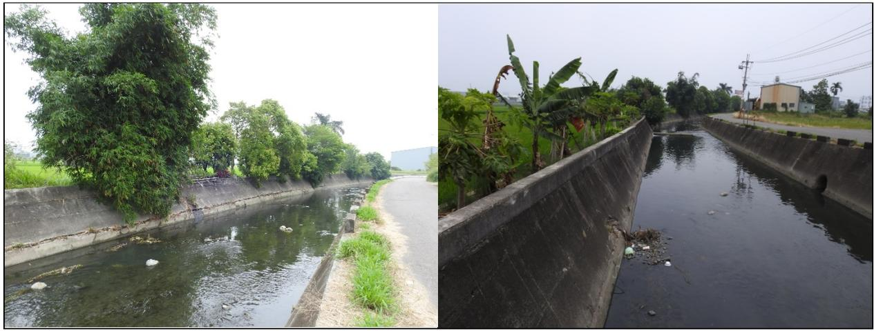
圖 12 保全岸邊樹木及鄰近田區垂直護岸需設置緩坡動物通道
