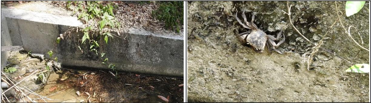
圖 33 0K+633 的上游區段過往不當的水泥固床工及垂直護岸設計
