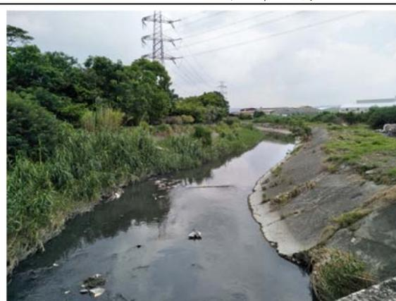
說明：混凝土斜坡護岸
