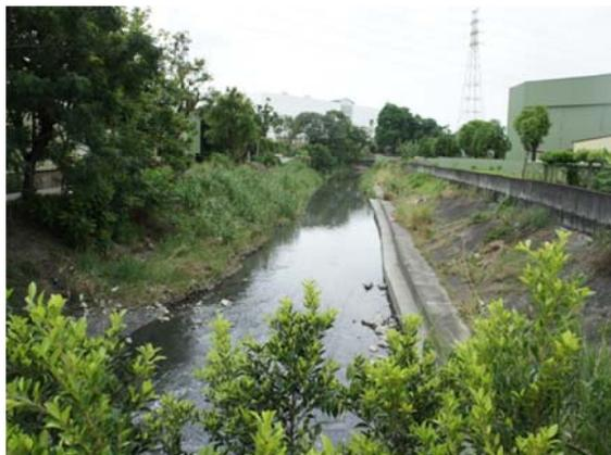
說明：混凝土斜坡護岸
