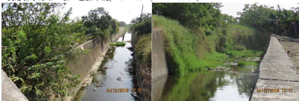
b.劉厝排水治理工程工區上中段(N23.134533, E120.198906)
