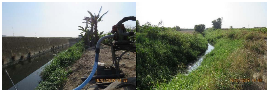
a.預定工區照片
