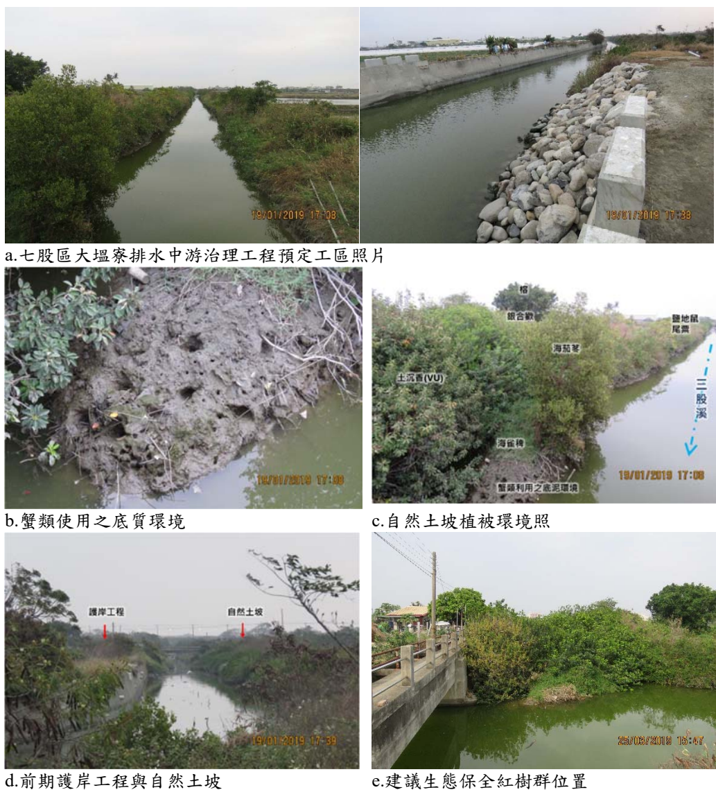
圖 4-97 七股區大塭寮排水中游治理工程現場勘查狀況。
