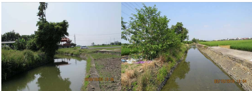
a. 白河區烏樹林排水護岸改善工程預定工區照片
