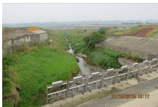
a. 預定工區照片
