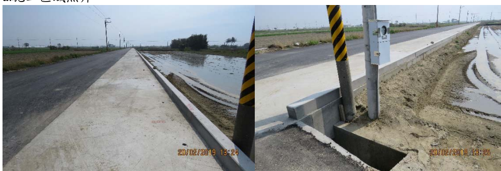
圖 4-117 將軍區保源中排一護岸改善工程現場勘查狀況。
