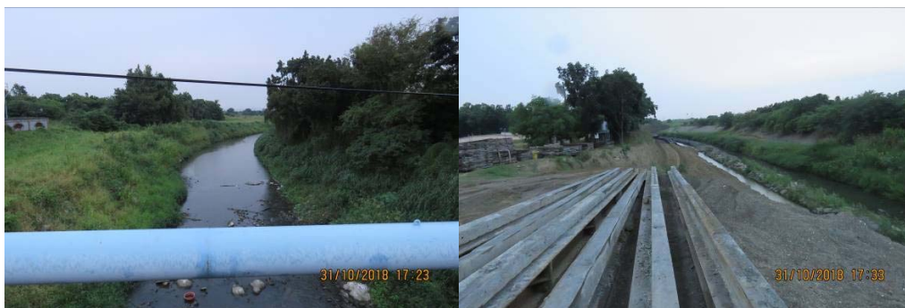
a. 預定工區照片
