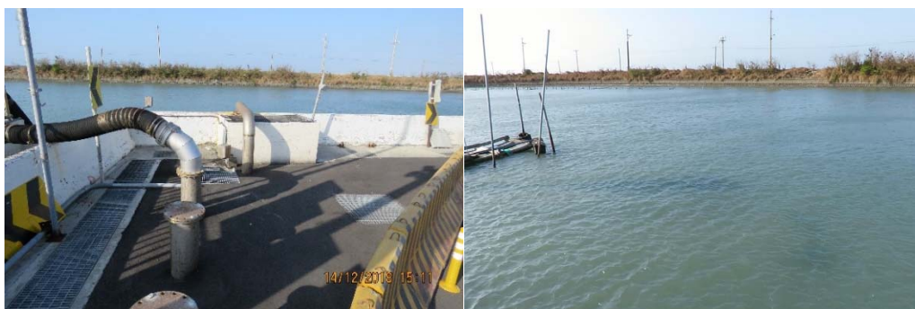
a.將軍區青鯤鯓社區部落防護治理工程預定工區照片
