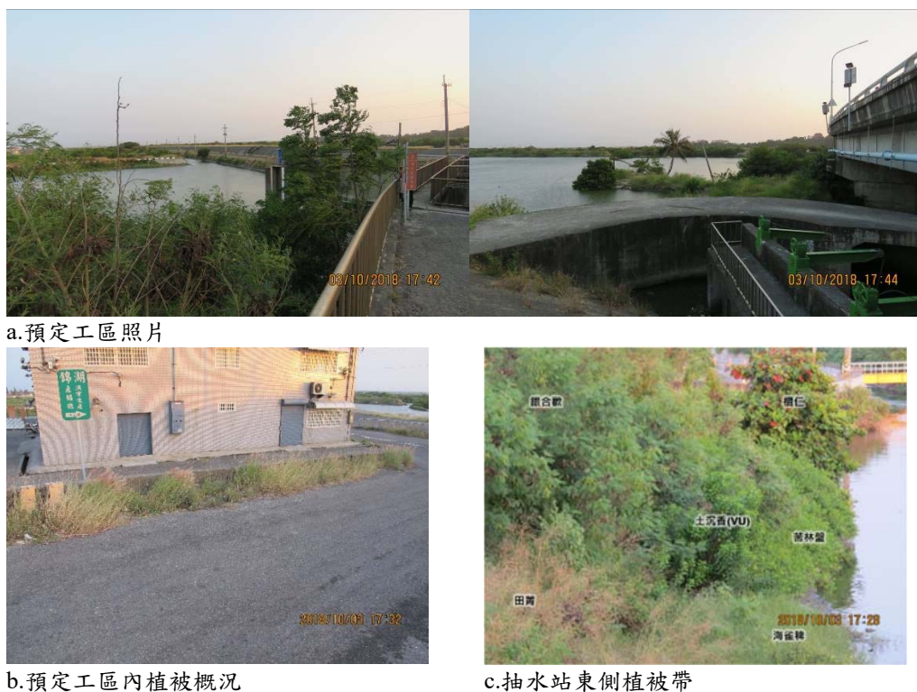
圖 4-13 新圍抽水站老舊抽水機組及附屬設施更新改善工程現場勘查狀況。
