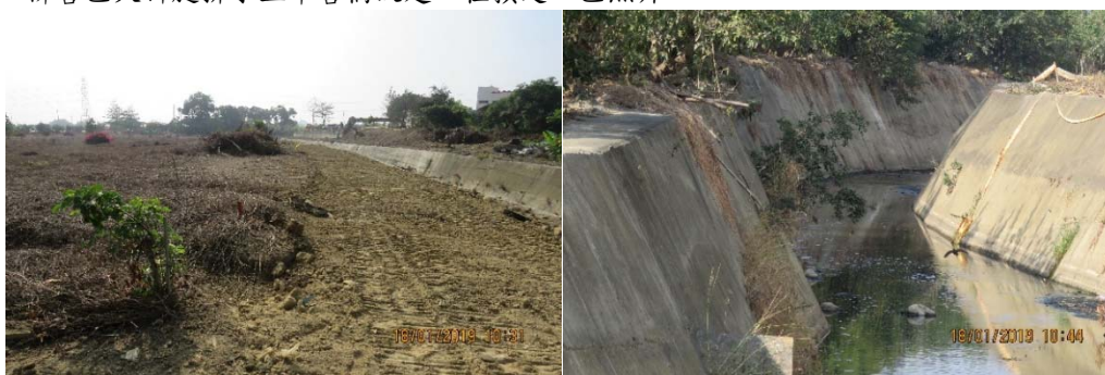
b.柳營區大腳腿排水五軍營橋上游段治理工程預定工區照片
