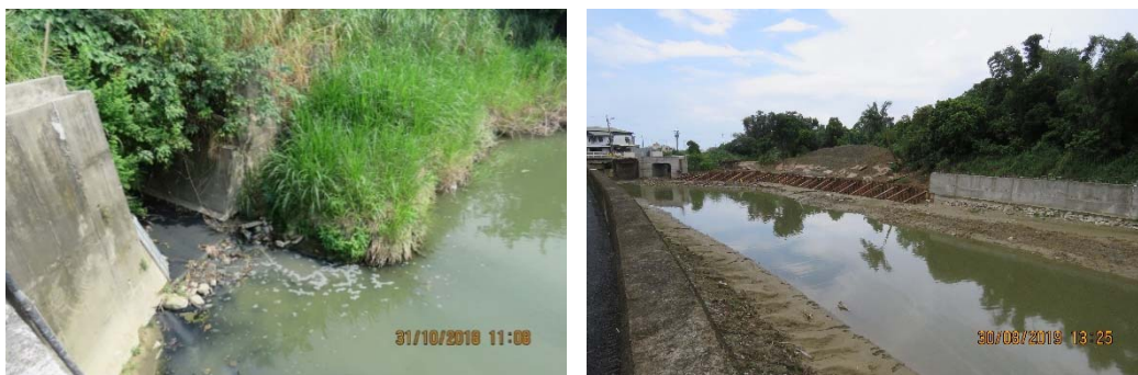
c.工區旁支流排水所排之農業排水
