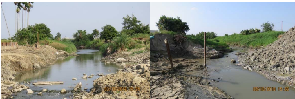
a.預定工區照片
