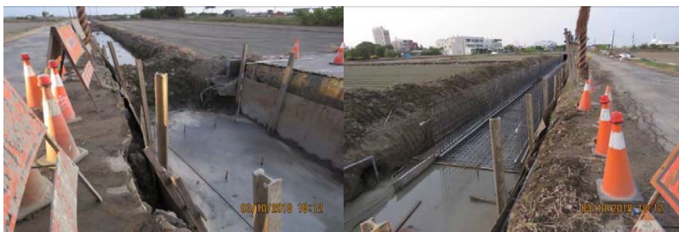
a.施工區域照片
