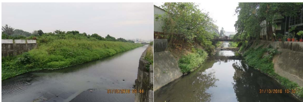
a. 預定工區照片
