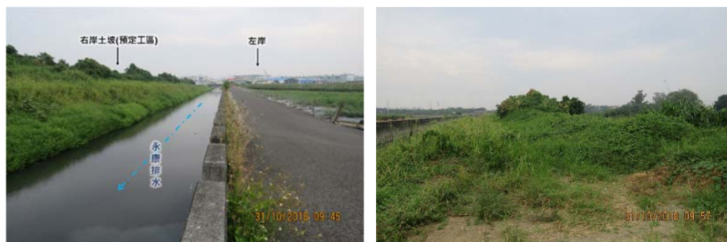
c.永康排水下游段 d.下游段右岸荒廢草生地 圖 4-57 永康區永康排水段護岸(右岸)治理工程現場勘查狀況。
