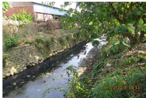
c.喬木林帶類型環境照。左岸為土坡，右岸為漿砌石護岸
