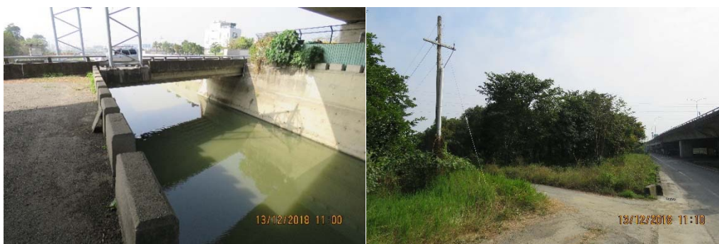
a.仁德區港尾溝溪排水(台 86 下方)護岸治理工程預定工區照片
