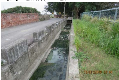
b.預定工區照片(二工區)
