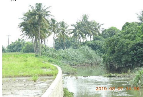
e.建議保留預定工區兩旁之大樹。
