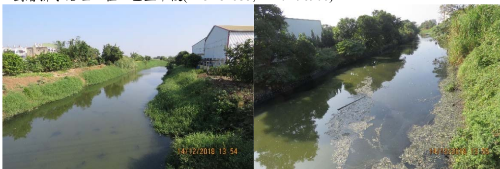
c.劉厝排水治理工程工區中段(N23.130594, E120.179944)
