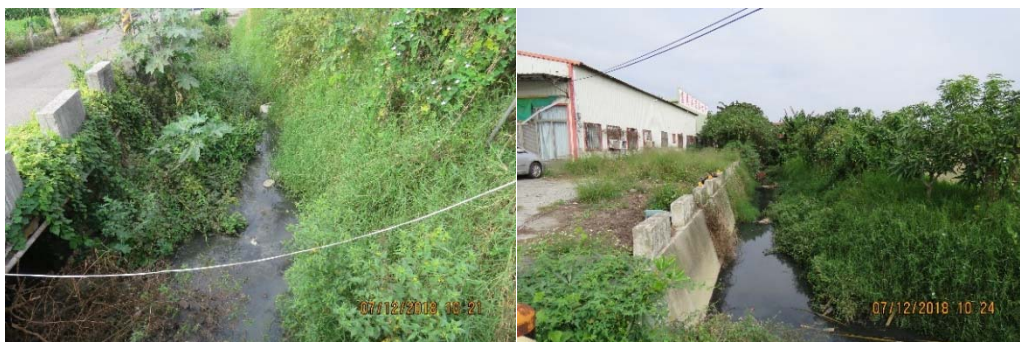
a.佳里區蘇厝寮中排上游段治理工程預定工區照片
