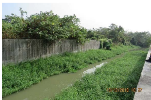
a. 預定工區照片
