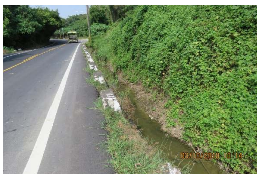
a. 預定工區照片
