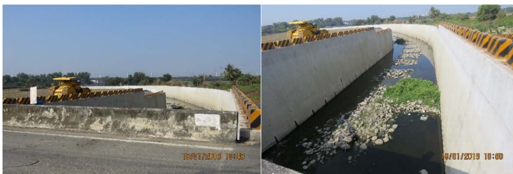
a.柳營區大腳腿排水五軍營橋改建工程預定工區照片
