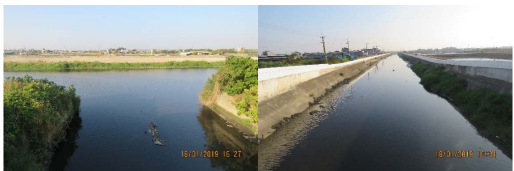
a. 預定工區照片
