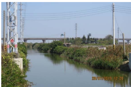
a.預定工區照片
