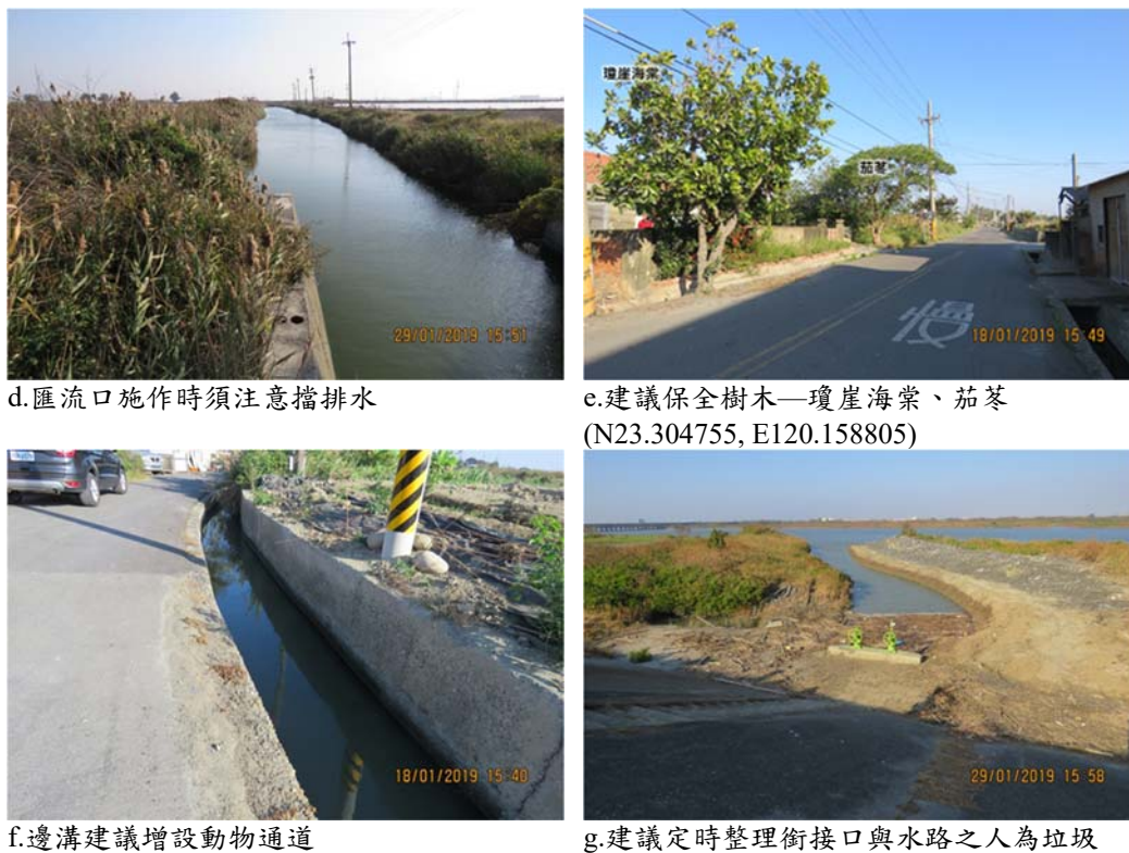
圖 4-136 北門區北馬社區部落防護治理工程現場勘查狀況。
