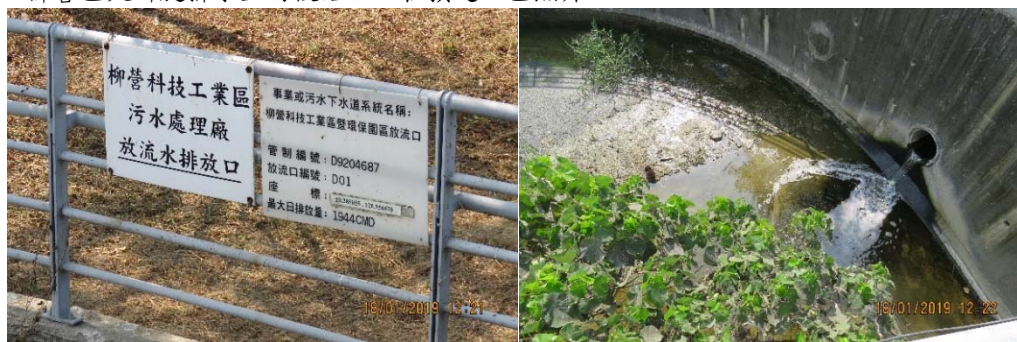
b.柳營區大腳腿排水上游段治理工程工區段水質受工業區汙水廠之排水汙染
