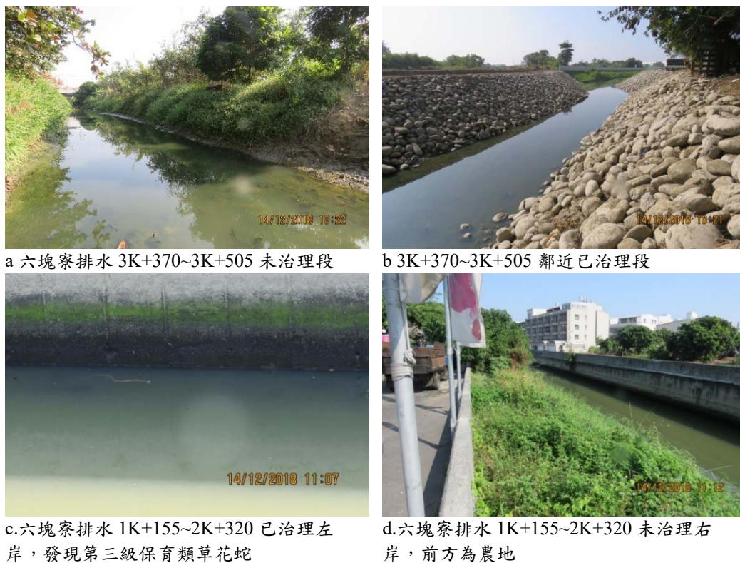
圖 4-144 六塊寮排水 1K+155~2K+320、3K+370~3K+505 治理工程現場勘查狀況。
