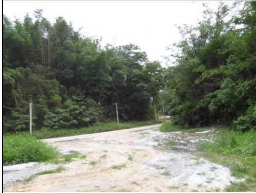
輸泥管施工範圍環境現況
