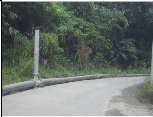
輸泥管施工範圍環境現況
