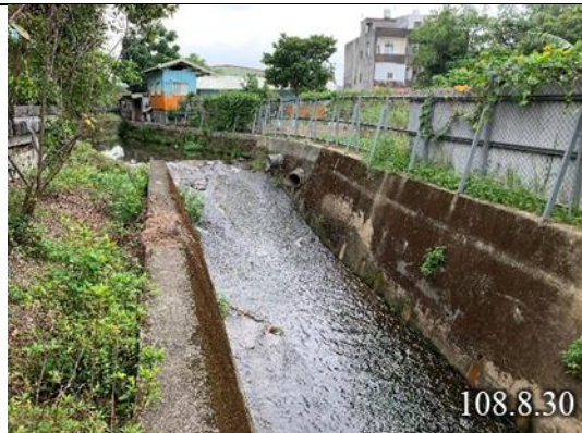
街口溪大溪國中上游混凝土斜坡
