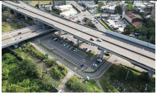
位置:舊社出入口停車場 概述:維管階段 日期:2023/7/12
