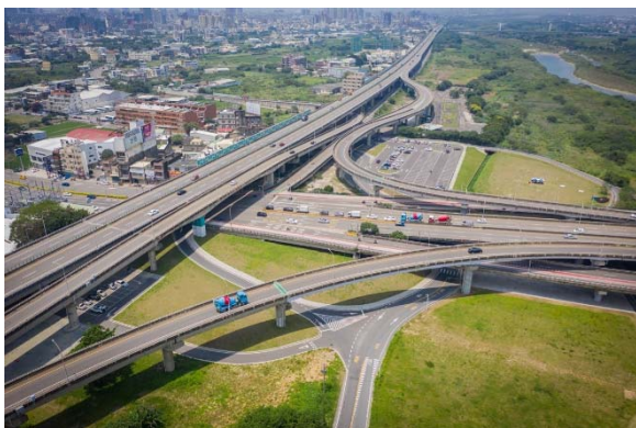
資料來源:竹市微笑水岸計畫 概述:完工後
