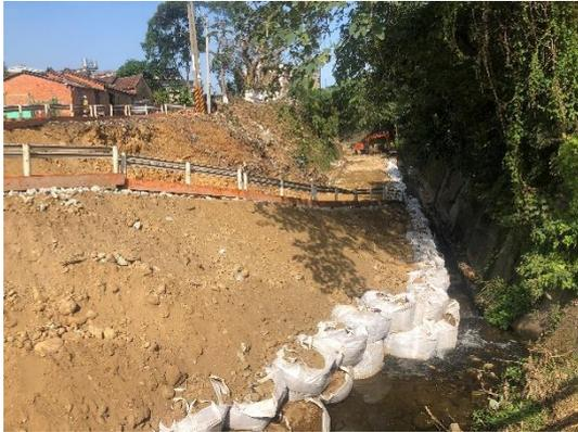
本公司本於愛護自然生態的理念，施工期間，除持續原設計數量之太空包堆置外，更派員隨時監看溪流是否因施工開挖造成混濁，並視情況調整並增加太空包數量，以避免混濁溪流造成生態破壞及生物死亡。
