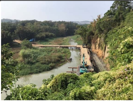
資料來源:竹市微笑水岸計畫 概述:施工中
