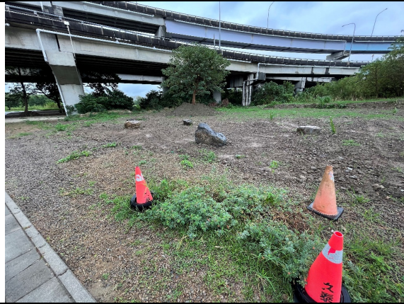
已掘除植群(毛木藍保留) 110.10.22
