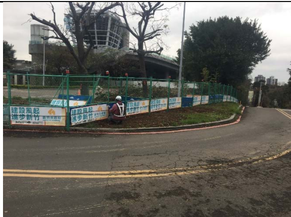
資料來源:竹市微笑水岸計畫 概述：施工前
