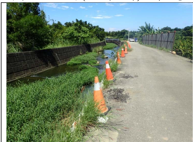
環境照-工程起點(洗衣區下游約 150 公尺處)
