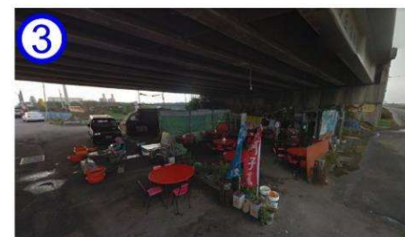
台61高架橋下空間占用
