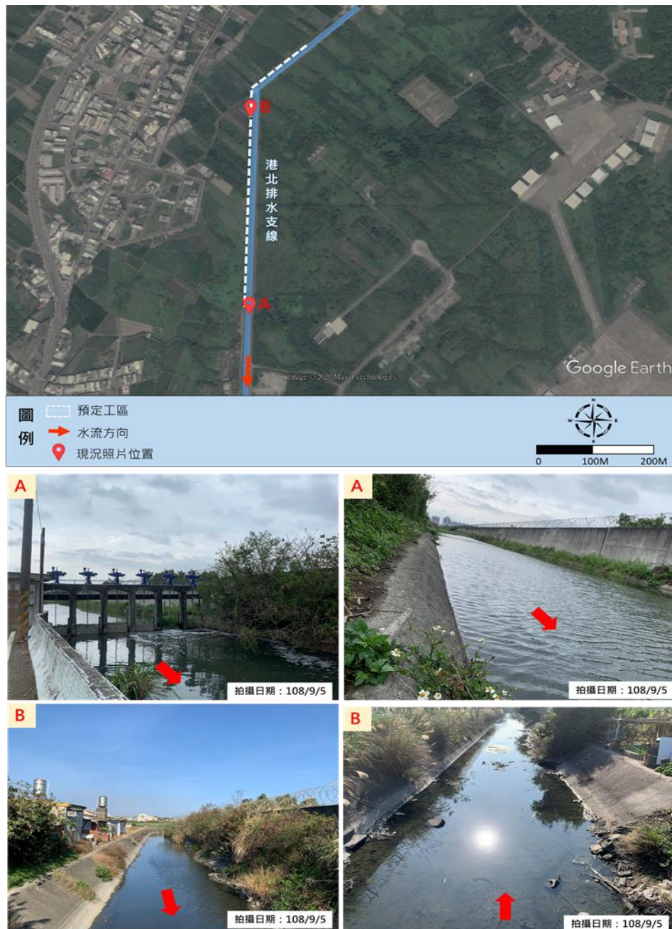
圖 3-5 港北排水支線(3K+091-791)右岸護岸加高應急工程之環境現況照
