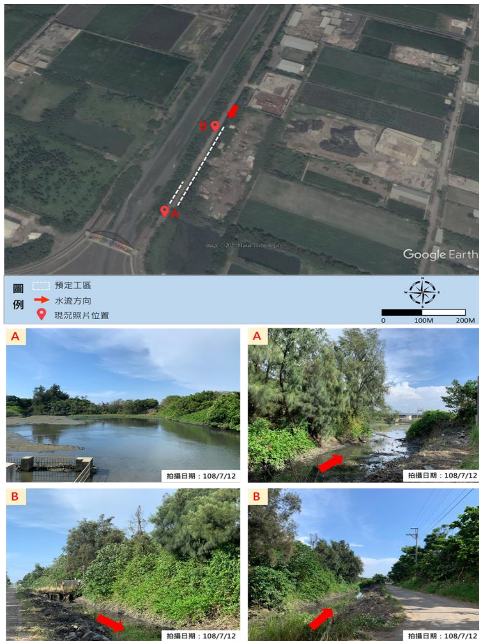
圖 3-2 港北金城橋排水幹線護岸新建應急工程(0K+090-0K+302)環境現況照
