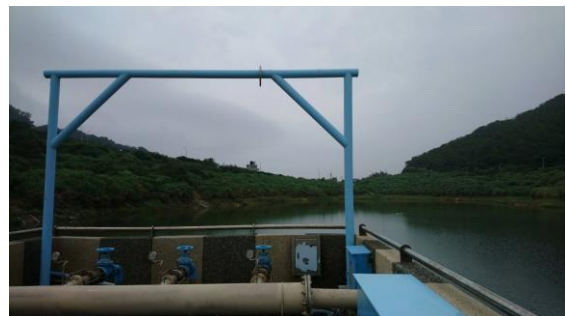
照片 4 坂里水庫
