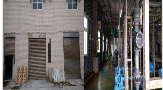
照片 2 南竿海水淡化廠
