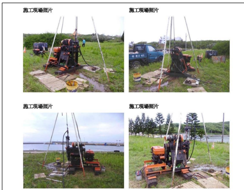
圖 3-13 鑽探施工照片
