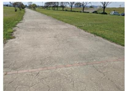
10 舊有步道鋪面為壓花地坪，部分龜裂坡損狀況，以混凝土補修缺乏整體性。
