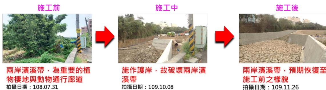
圖 3-44 「新豐鄉中崙支線排水護岸改善應急工程」棲地影像監測圖
