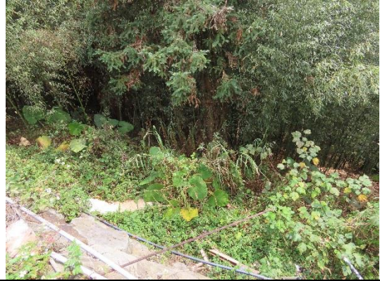
邊坡現況 拍照日期：110年3月3日
