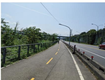
19 自行車道臨於堤外便道側，與車道間設有緣石車阻及反光導標。
