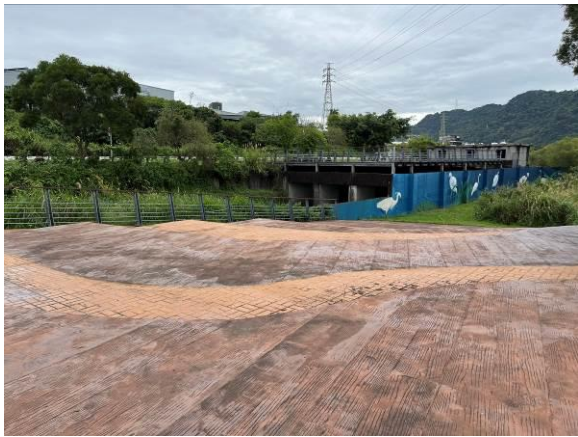
階梯廣場與甲九圳出水口箱涵
