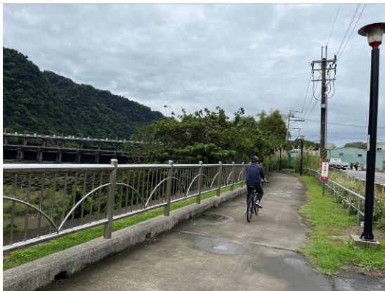
鳶山堰下游左岸自行車道
