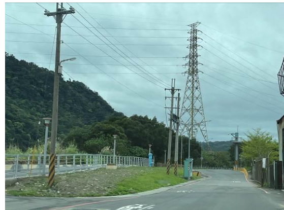
鳶山堰下游左岸自行車道
