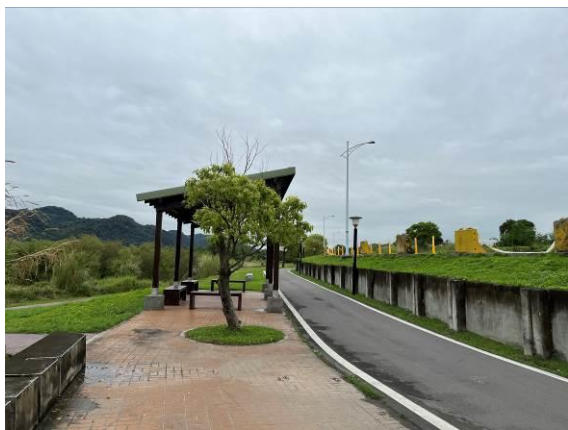
自行車道側牆與休憩涼亭
