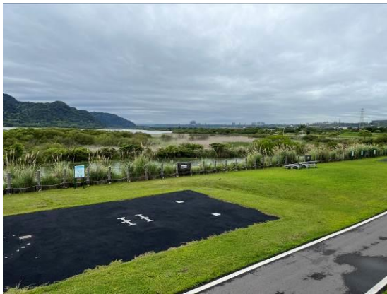
部分體建設施已拆除待更新
