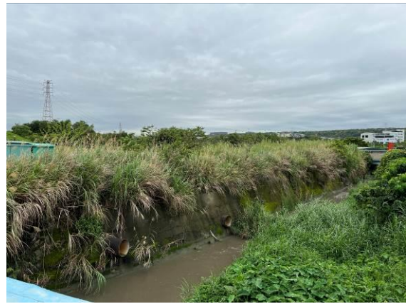
甲九圳護岸現況
