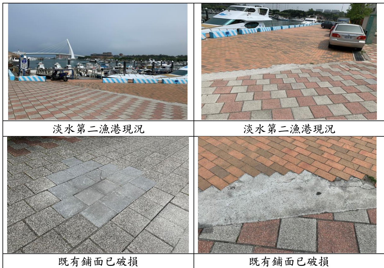
圖 7、人行步道鋪面現況照片
