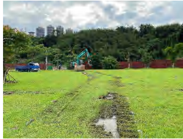
111.05.17/A區假儉草皮施工情形
