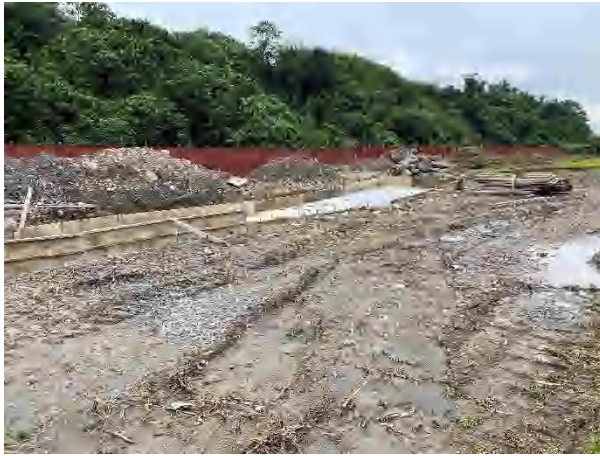
111.05.17/A區假儉草皮施工情形
